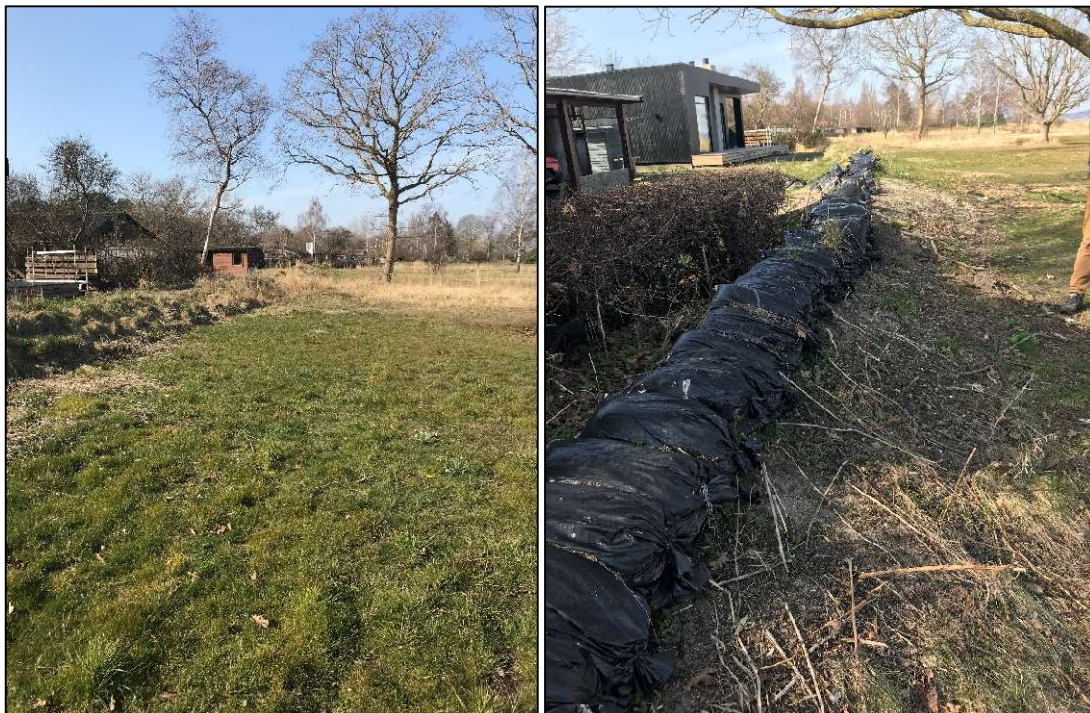
Figur 2.17: Til venstre: Diget ud for matrikel 13bd set mod vest. Foto: NIRAS (d. 22-3-2022). Til højre: Sandsække ovenpå diget ud for matrikel 13be set mod vest. Foto: NIRAS (d. 22-3-2022).
