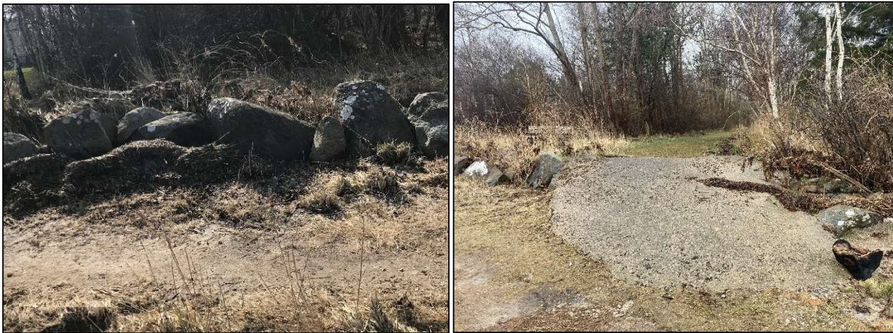
Figur 2.10: Til venstre: Forhøjning i terrænet på matrikel 1f. Foto: NIRAS (d. 22-3-2022). Til højre: Overgang over forhøjningen mellem matrikel 1n og 1f. Foto: NIRAS (d. 6-4-2022).
