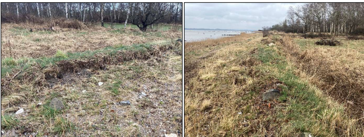
Figur 2.11: Nedbrudt dige med erosionskår ud for matrikel 1d. Til venstre: Set mod land/sydvest. Foto: NIRAS (d. 6-4-2022). Til højre: set mod øst fra toppen af diget. Foto: NIRAS (d. 6-4-2022).
